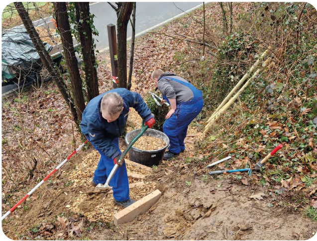
Naturtreppe im Bau.
